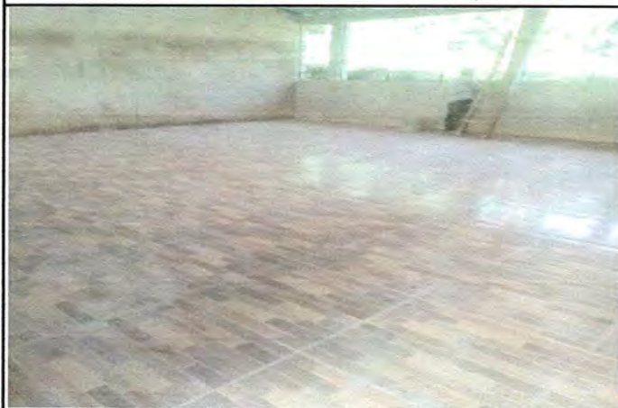
Foto 3: Finalización torta piso aula, adicional piso cerámico
