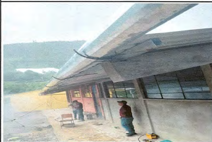
Foto 4: Finalización Instalación Canaleta caída de agua Adicional
