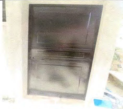
Foto 2: Instalación final de puerta al aula Adicional
