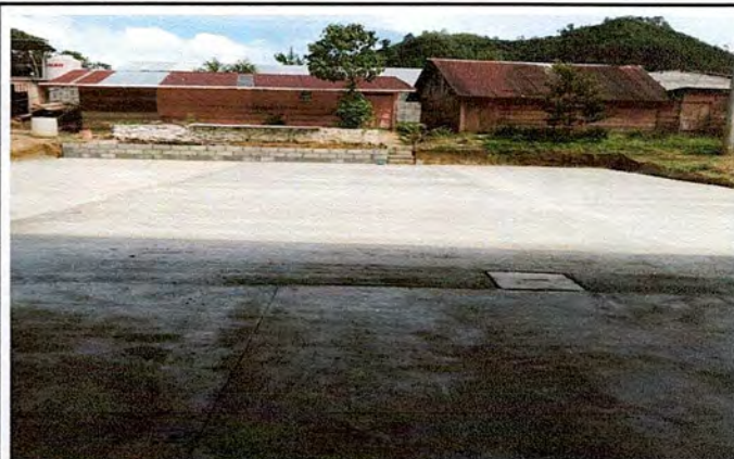
Foto 2: Finalización piso en patio
